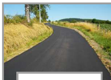
Renforcement de chaussée
